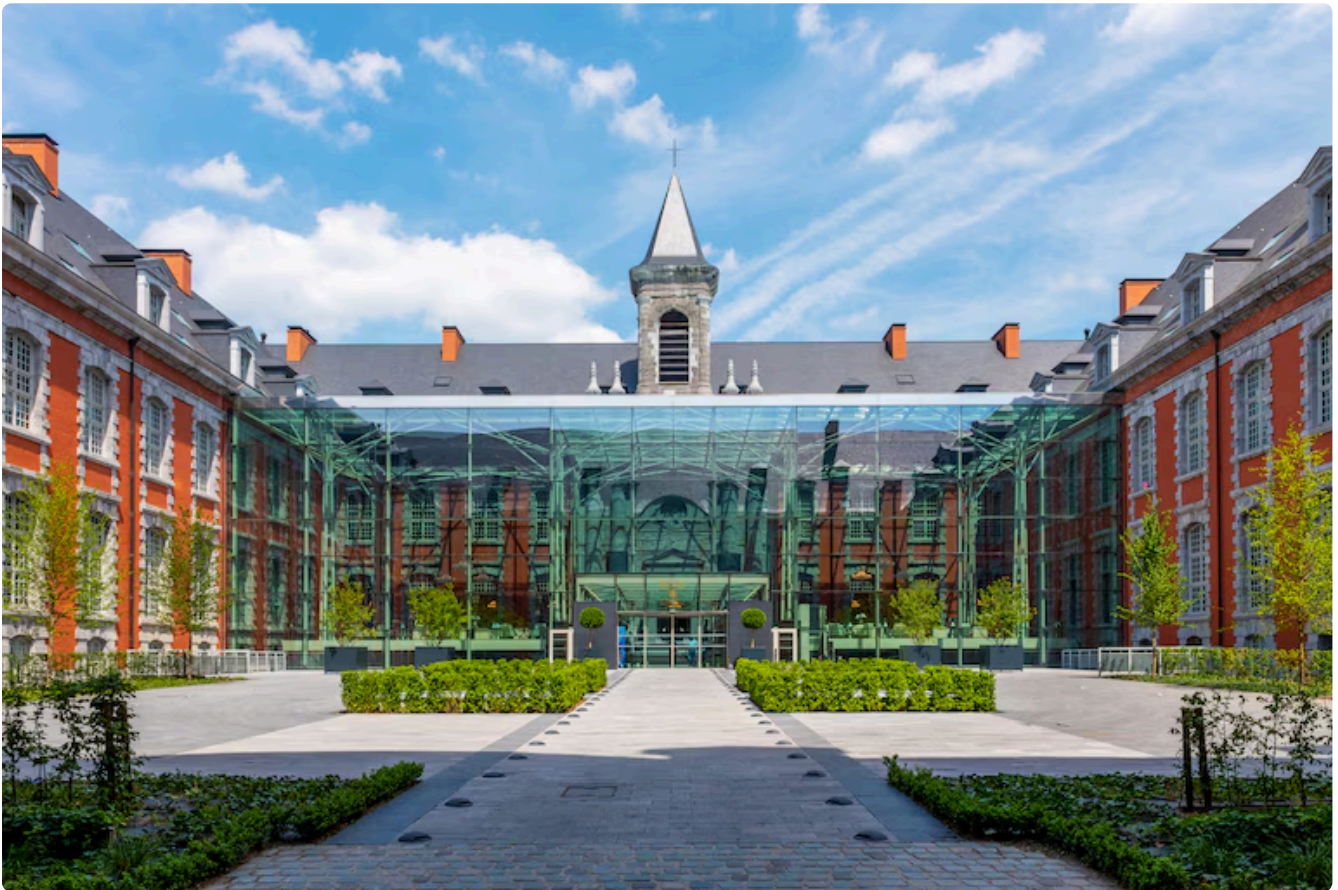
L'Ancien Hôpital Général de Valenciennes a été entièrement rénové. Durée des travaux: 6 ans ©VILLE DE VALENCIENNES
