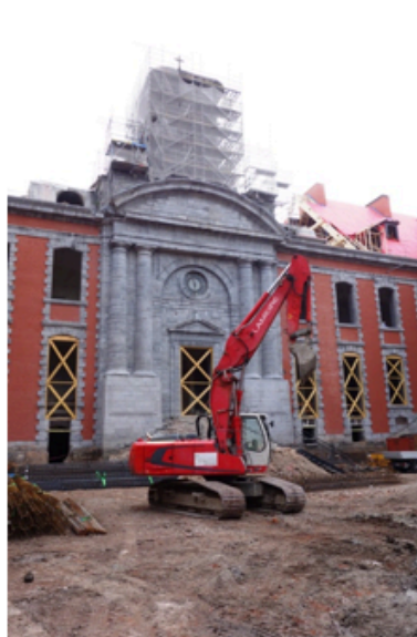
(photo extraite du site du CSPV)
